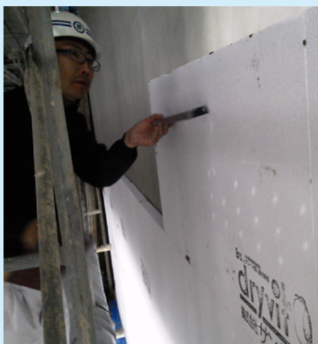
湿式工法による外壁の断熱改修の様子 ＝提供：（一社）日本建材・住宅設備産業協会
