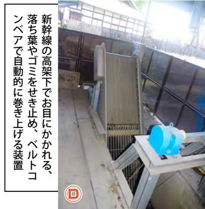
新幹線の高架下でお目にかかれる、落ち葉やゴミをせき止め、ベルトコンベアで自動的に巻き上げる装置
